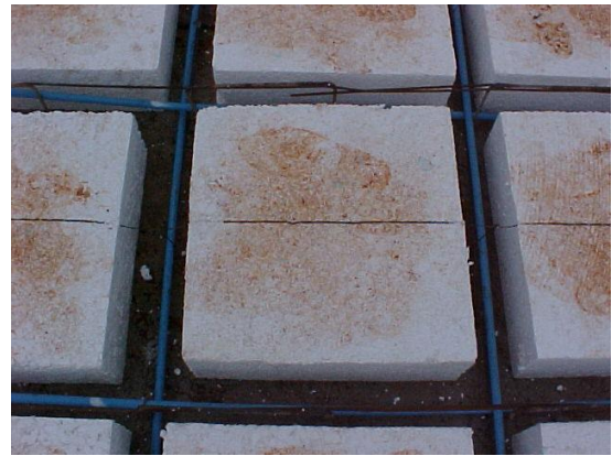
Figura 64 – Laje nervurada protendida com cordoalhas engraxadas e isopor como material de enchimento.
