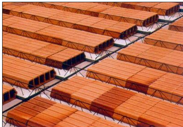
Figura 80 – Nervura transversal (FAULIM, 1998).
