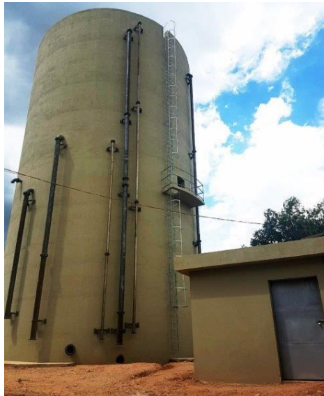
Figura 11 - Reservatório moldado in loco
